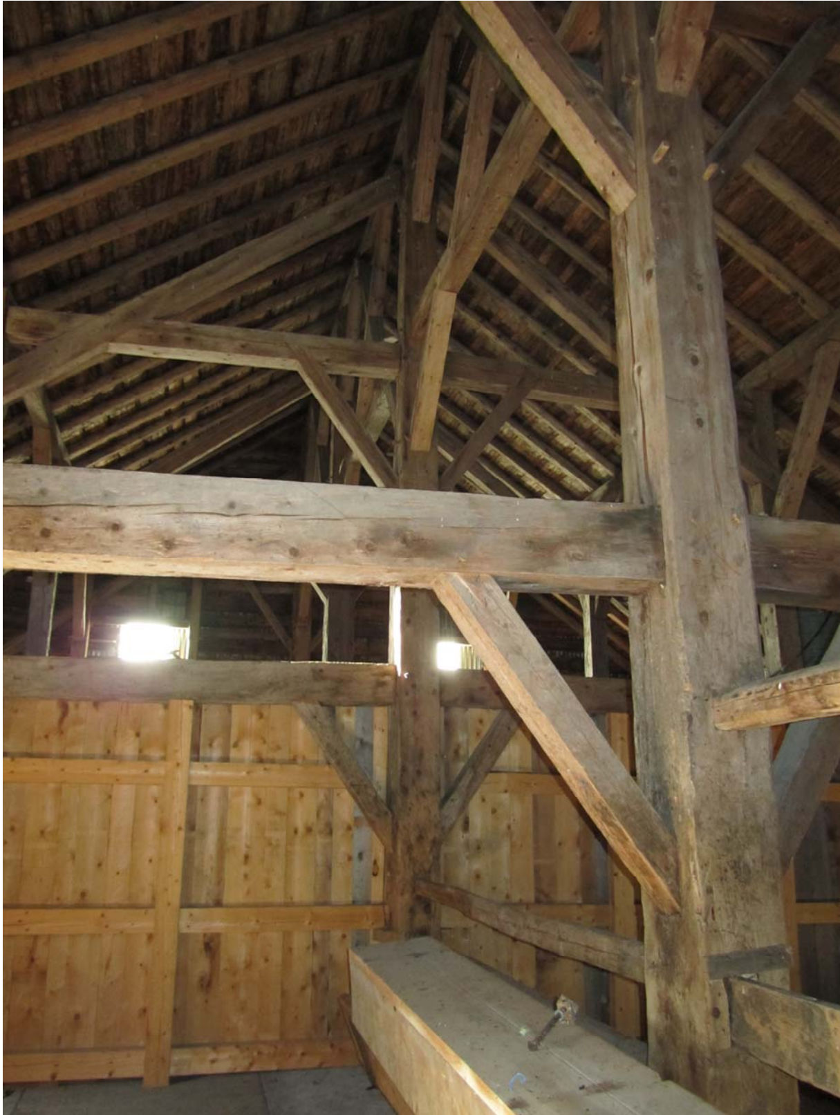
Une charpente magnifique et en parfait état malgré la vétusté générale du chalet.
